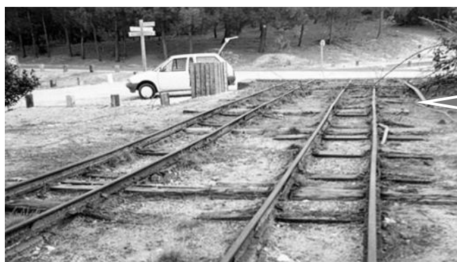
Pour l'entreposage des tonnelets de résine en aluminium, l'écartement a été déplacé à 43 cm, ce qui correspond à l'extérieur des 2 nervures circulaires de renfort des tonnelets.
