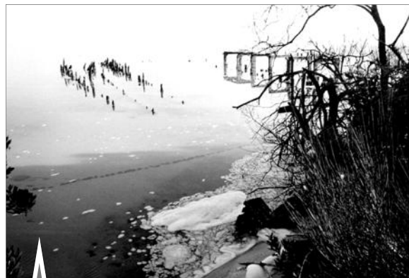
Anciens appontements sur le lac d'Hourtin : on peut supposer que celui en bois est le plus ancien, ensuite remplacé par l'ossature en béton.
