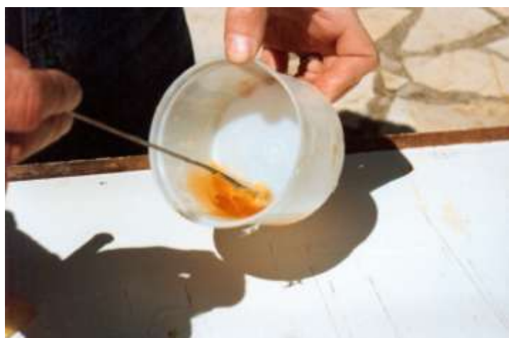
Photo 34 mélange de la résine il faut éviter de faire rentrer des bulles d'air (suivre les instructions données)
