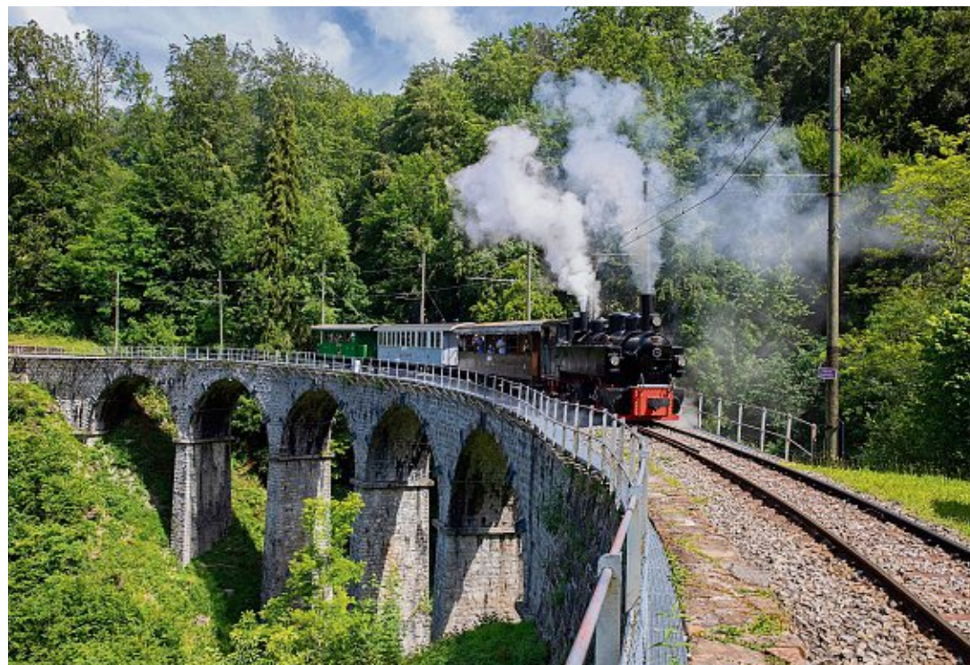
Le terrain s'affaisse sous la première voûte du viaduc (à g.). Elle sera remplacée. ODILE MEYLAN
